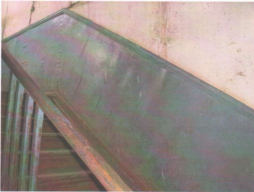
Фото №11. Подъезд, лестница .
