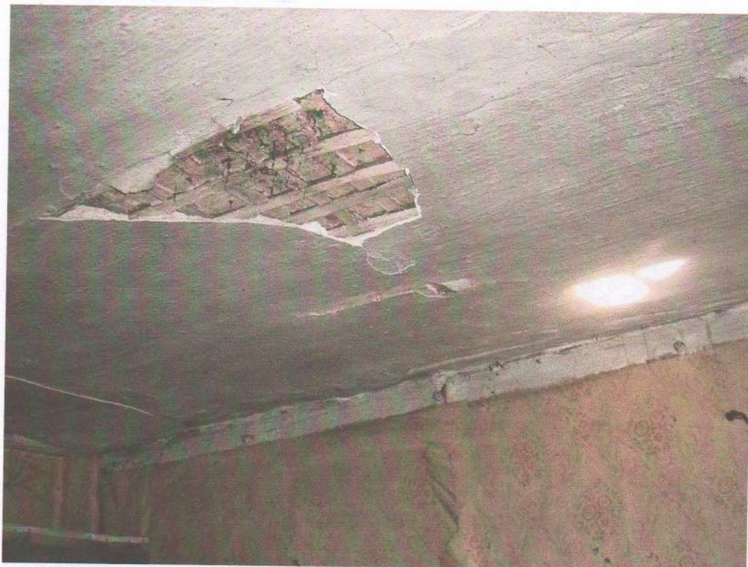
Фото №15. Стены, потолок.
